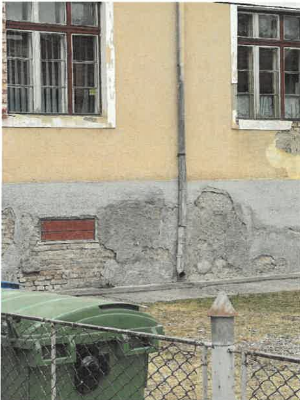
Degradari si avarii la corp C1. Cosuri de fum avariate cu pericol de prabusire, timpane cu inaltime mare fara contravanturi cu pericol de prabusire. Lipsa canalizarii scurgerilor produce avariarea finisajelor si a zidurilor precum si infiltratii in sol si in subsolurile aferente.
