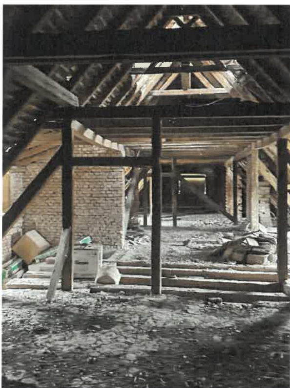
Pod corp C1. Avariarea materialului lemnos datorita infiltratiilor locale, agentilor biologici.
