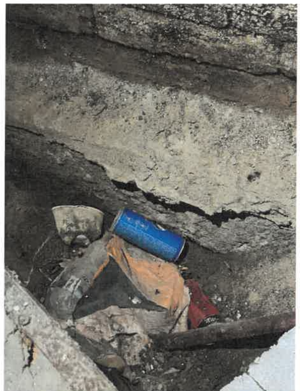
Subsolul mare, sub aripa centrala. Infiltratii in zidarii, sondaje la fundatii.
