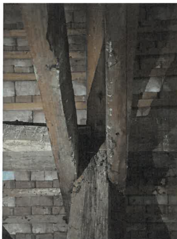
Pod corp C1. Avariarea materialului lemnos datorita infiltratiilor locale, agentilor biologici.
