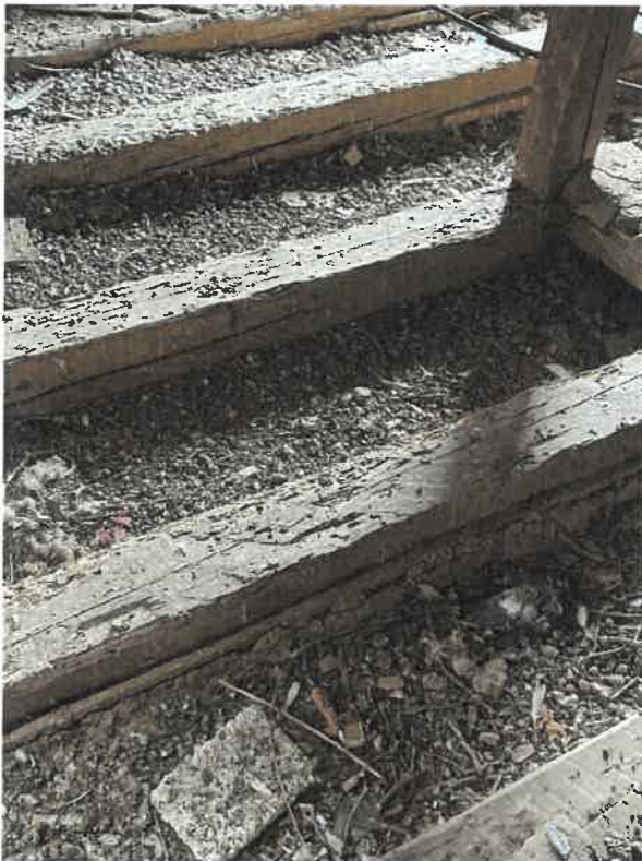
Planseu peste parter ingreunat de straturile de pamant, grinzi degradate si putrezite.
