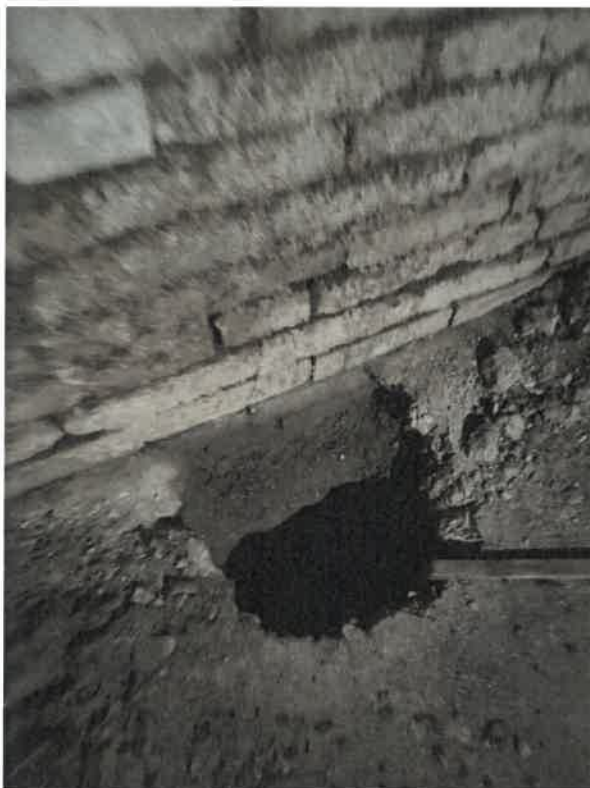
Subsolul mare, sub aripa centrala. Infiltratii in zidarii, sondaje la fundatii.
