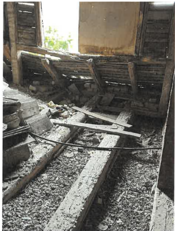
Planseu peste parter ingreunat de straturile de pamant, grinzi degradate si putrezite.
