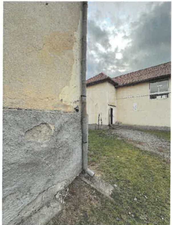
Degradari si avarii la corp C1. Cosuri de fum avariate cu pericol de prabusire, timpane cu inaltime mare fara contravanturi cu pericol de prabusire. Lipsa canalizarii scurgerilor produce avariarea finisajelor si a zidurilor precum si infiltratii in sol si in subsolurile aferente.
