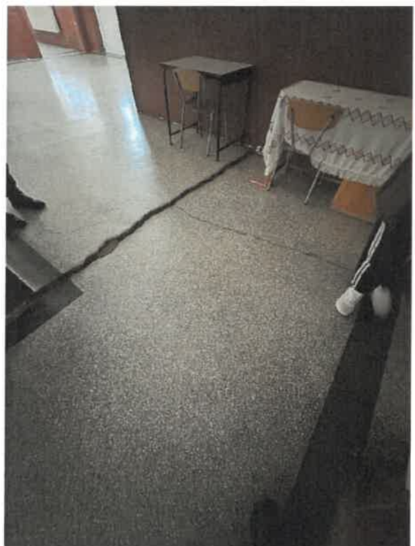
Avarii importante la interior in zona subsolului mic sub aripa dinspre drumul judetean. Tasarea peretelui coridorului datorita impingerilor de pamant si tassarilor peretelui de la subsol. Buiandrugul de la fereastra a cedat.
