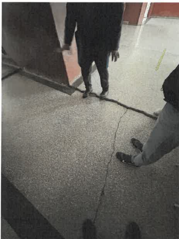
Avarii importante la interior in zona subsolului mic sub aripa dinspre drumul judetean. Tasarea peretelui coridorului datorita impingerilor de pamant si tassarilor peretelui de la subsol. Buiandrugul de la fereastra a cedat.
